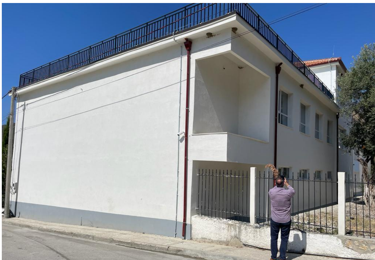
Fig. 12,13: Punime termoizolim tarace / Punime në çati
