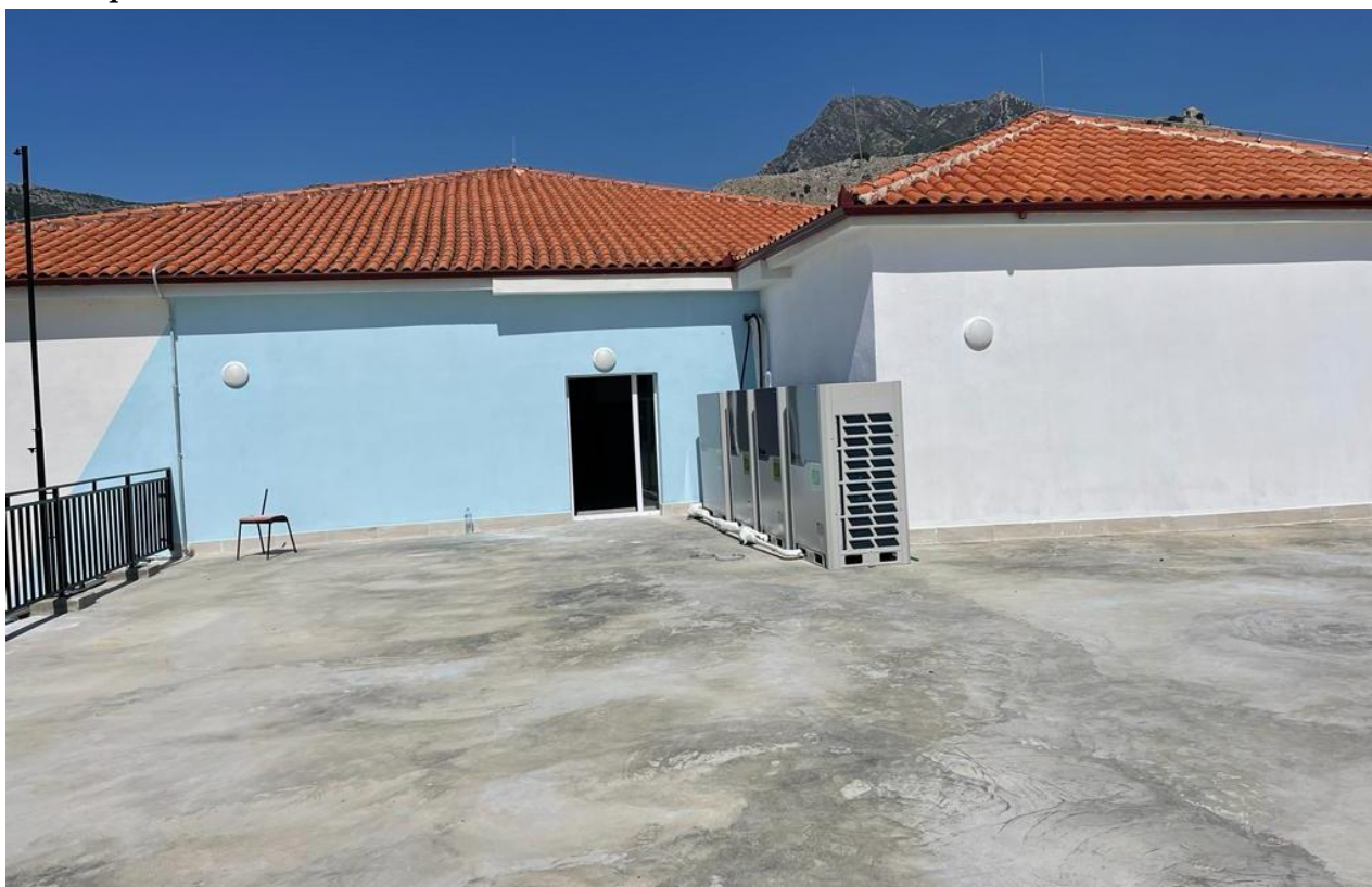
Fig. 10,11: Punime termoizolimi të jashtëm / Punime dritësh / Punime tarace / Punime rampe
